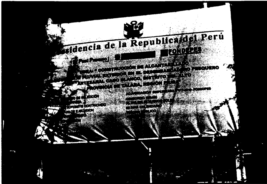
Colocación de Cartel de Obra.
