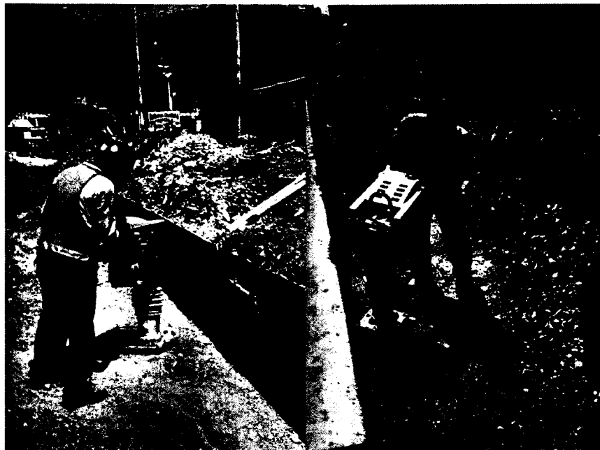
Conformación de Subrasante.
