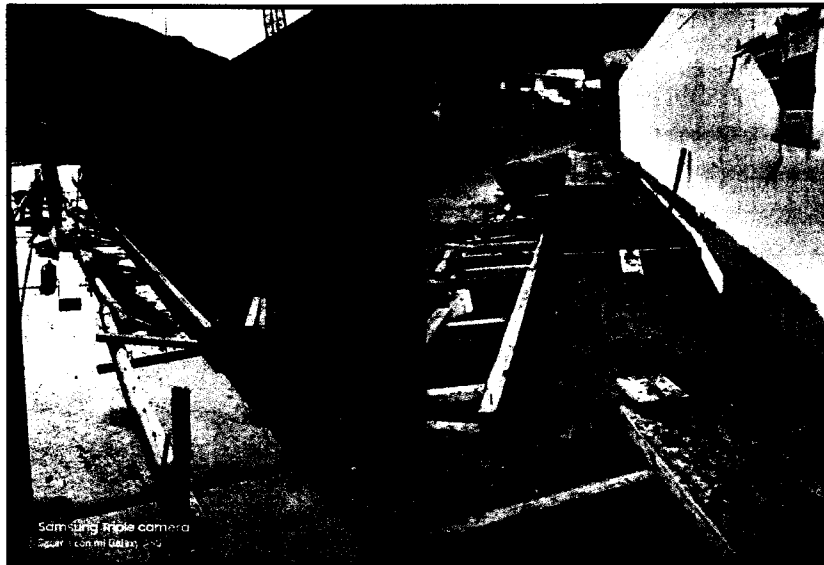
Encofrado y Vaciado de Vereda f'c=175 kg/cm 2 .
